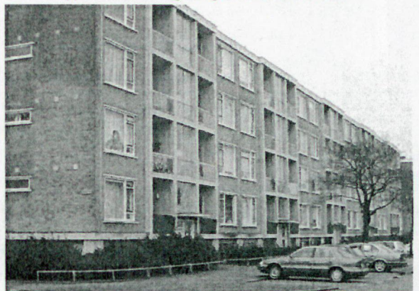
Foto 4: appartementen 'nog niet gerenoveerd' ca. 1995
