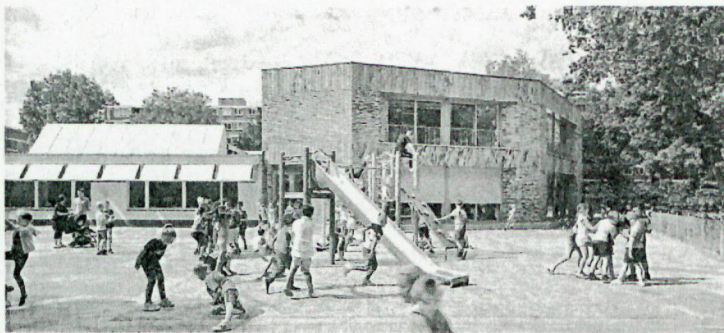
Impressie obs 5.1.2e, Haarlem. Links gerenoveerd deel, rechts uitbreiding. (Bron: 5.1.2e)
