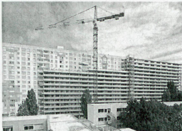
Grand Parc tijdens de transformatie. Links is de oude gevel zichtbaar, rechts worden de uitbreidingen met wintertuinen en balkons geplaatst. (Bron: 5.1.2e )
