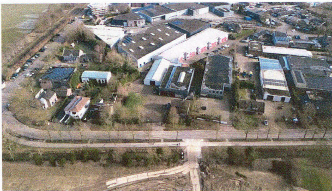
Foto 1: Genomen van Westzijde in oostelijke richting
