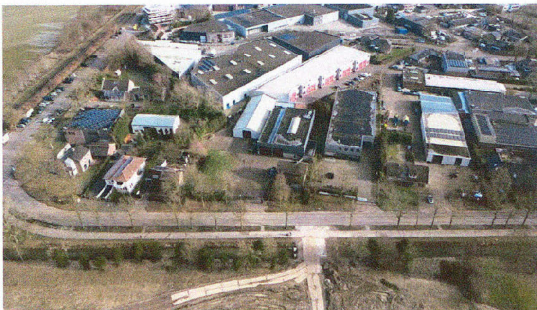
Foto 1: Genomen van Westzijde in oostelijke richting
