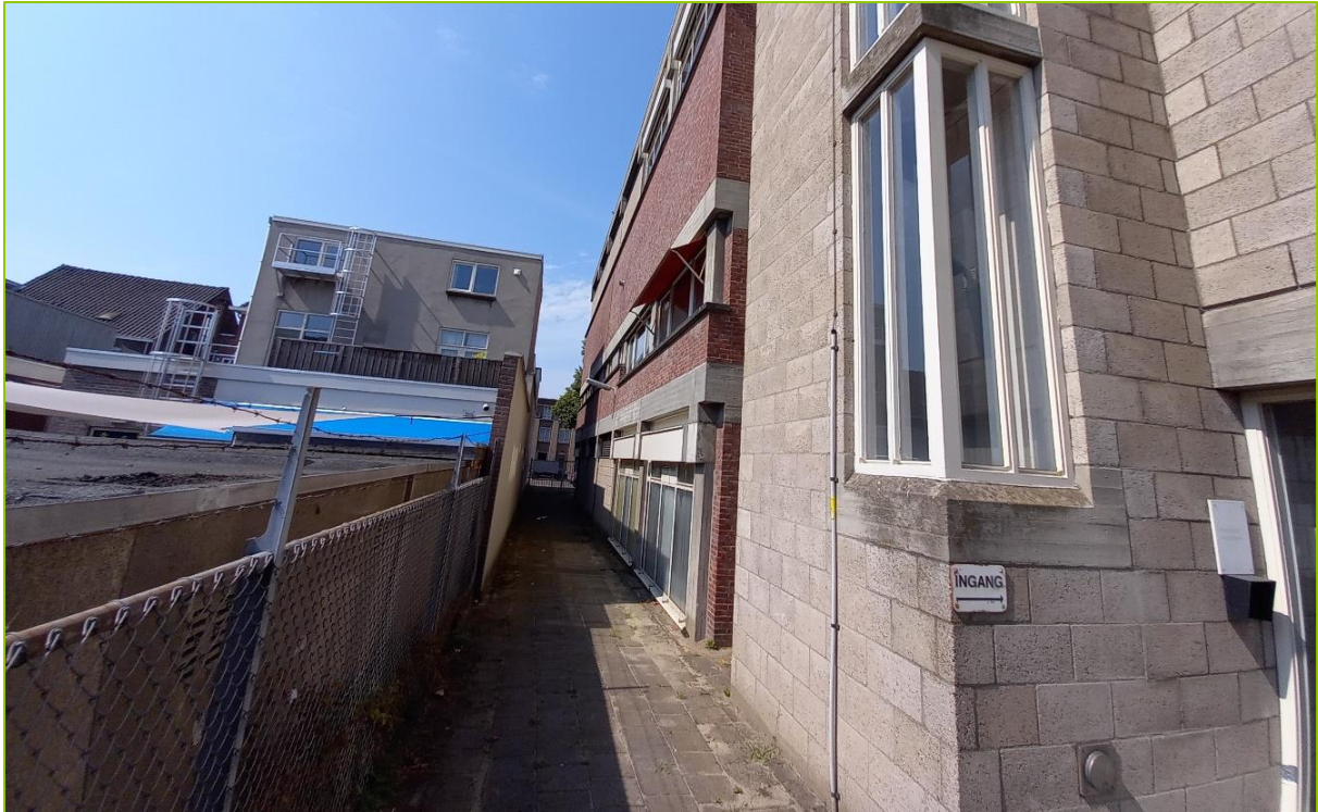
De gevels zijn uit verschillende typen steen opgetrokken.
